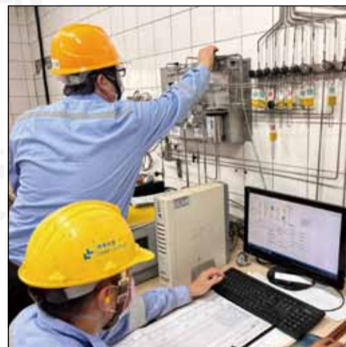
↑義大醫院藥劑部聯合工務處和職業安全衛生室至醫用氧氣灌站實地訪查。
